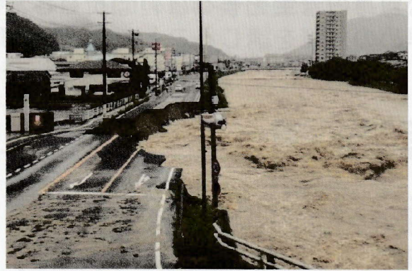
写真提供：国土交通省中国地方整備局
